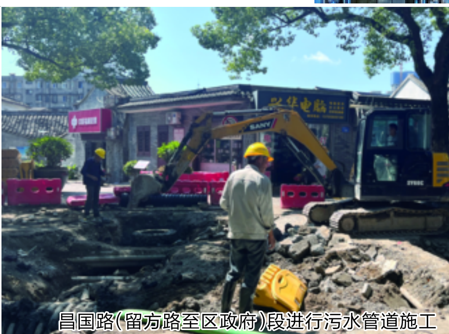
昌国路(留方路至区政府)段进行污水管道施工
